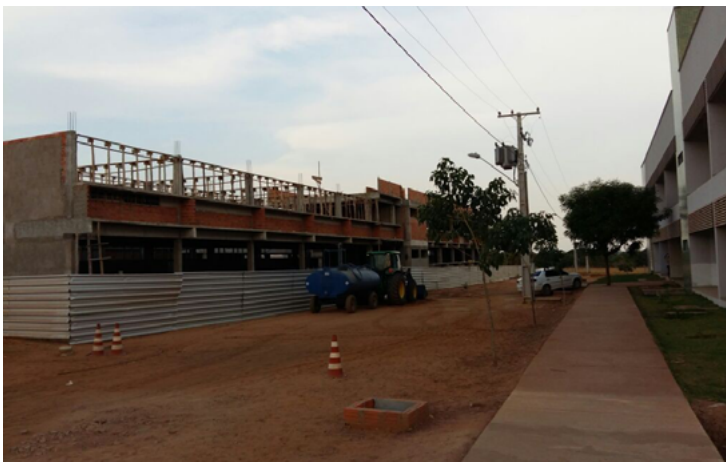
Foto 4 - Novos prédios em construção do IFTO de Colinas do Tocantins
